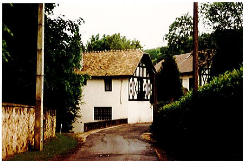
Pont et moulin du Pré-Joly
