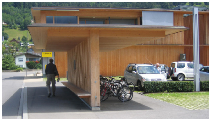
Abri bus, attaches vélos (même abri en bois) et parking voitures regroupés (Ludesh, Autriche)
