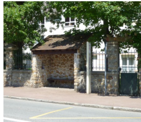
Abri bus en meulière incorporé à une limite de propriété (St-Rémy-lès-Chevreuse 78)
