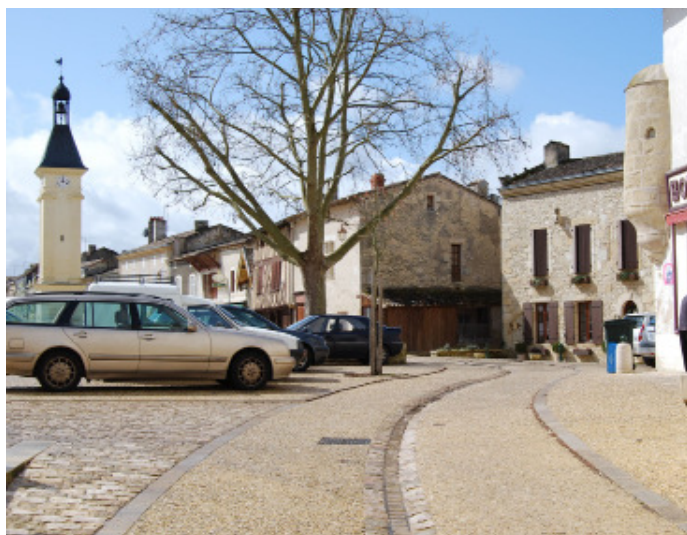
Aménagement des circulations par le changement de revêtement et les caniveaux pavés (Gensac, Gironde 33)
