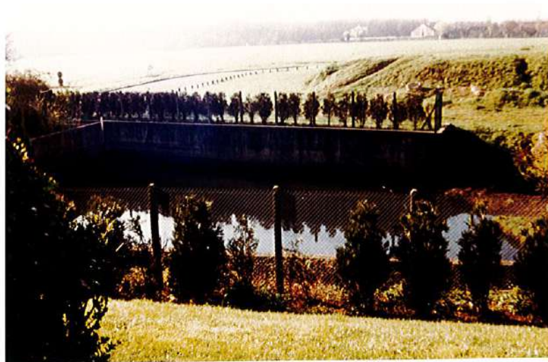
Bassin de retenue - hameau du Buisson
