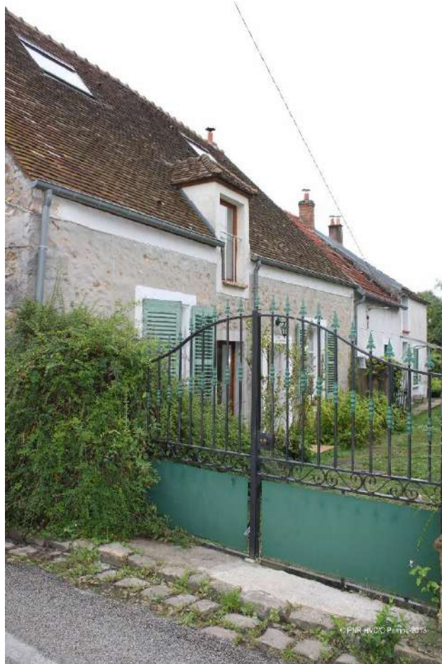
Maison rurale du 22 rue du Bon Puits, 2013
