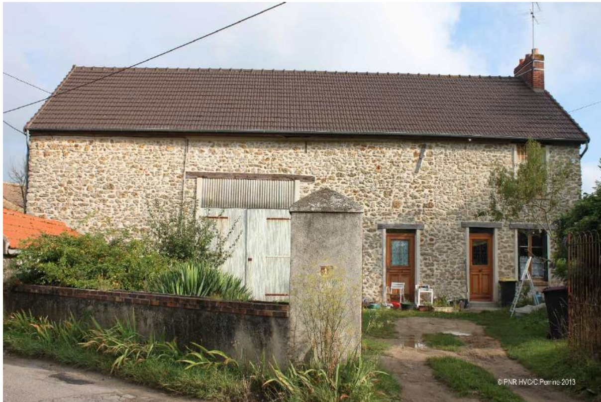
Maison rurale du 1 rue de Saint-Méry, 2013
