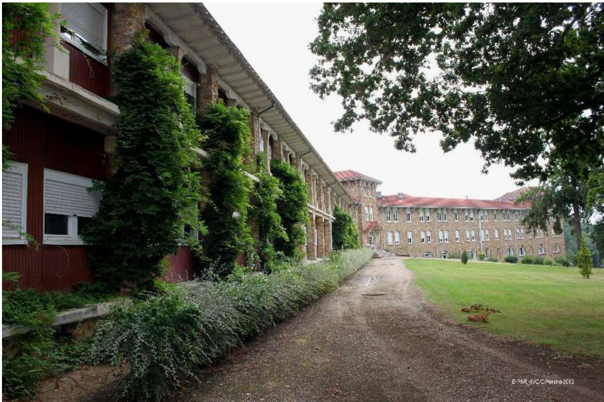
Façade sud du pavillon Despeaux, 2013
