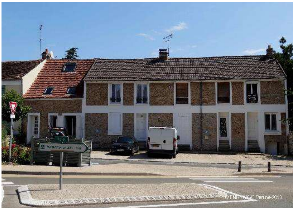
Maison de bourg, place de la Mairie, 2013
