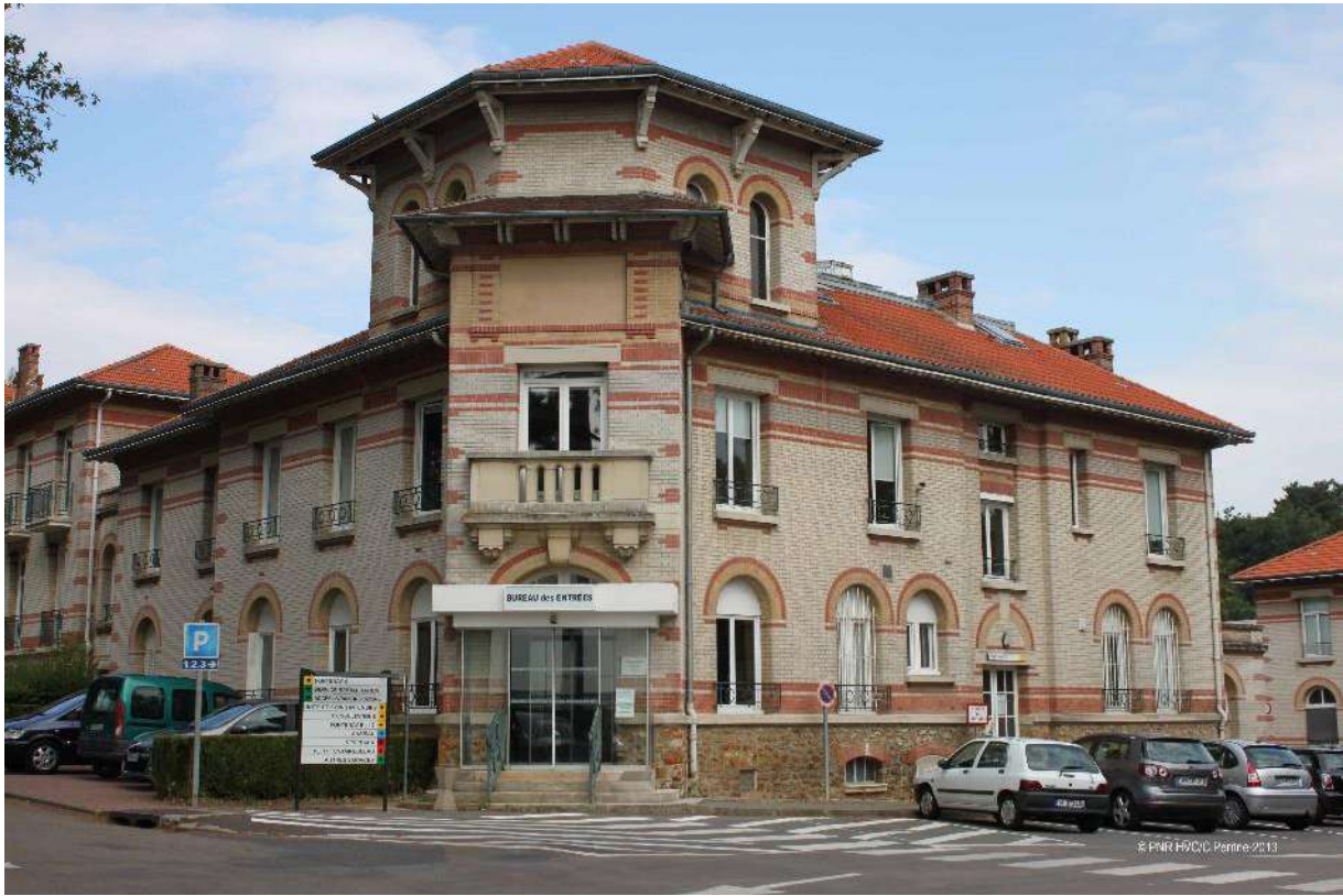
Façade sud-est du pavillon Fontenay A, 2013
