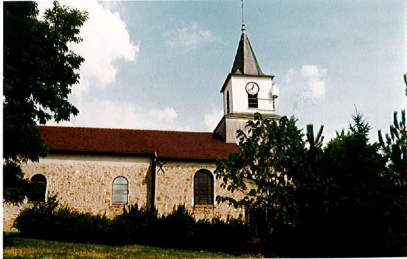
Eglise paroissiale Saint-Christophe
