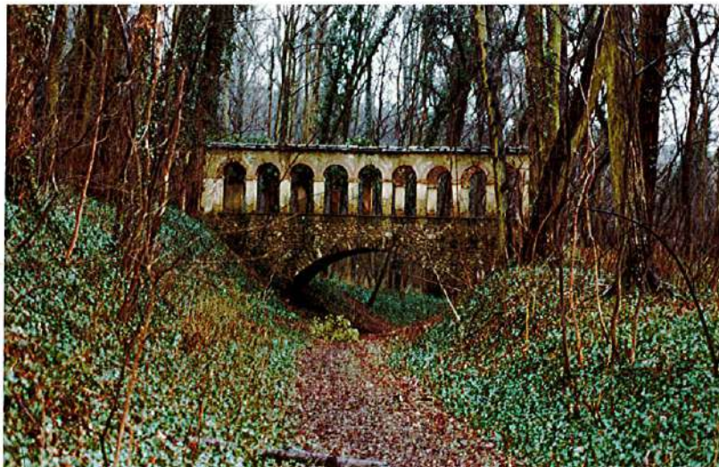
Pont galerie du château d'Orce
