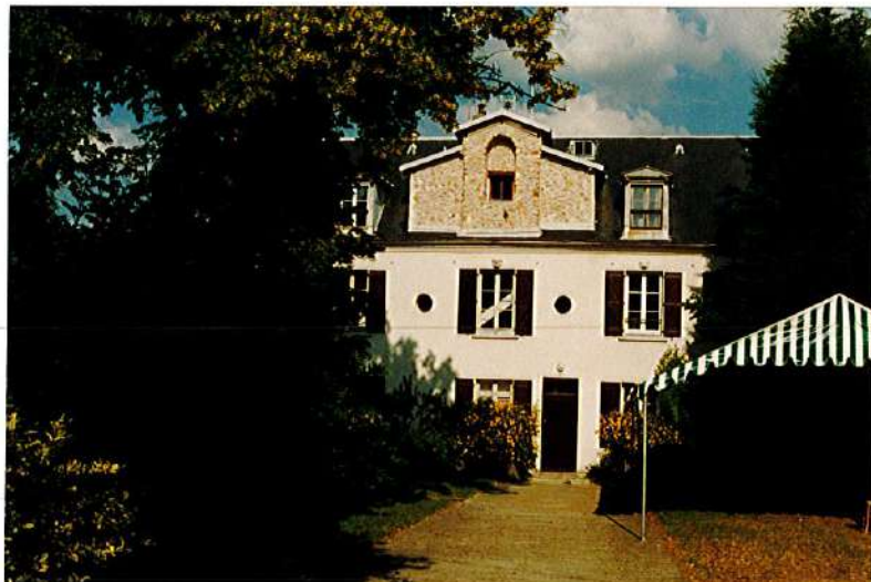
Prieuré Saint-Christophe : bâtiments d'accueil
