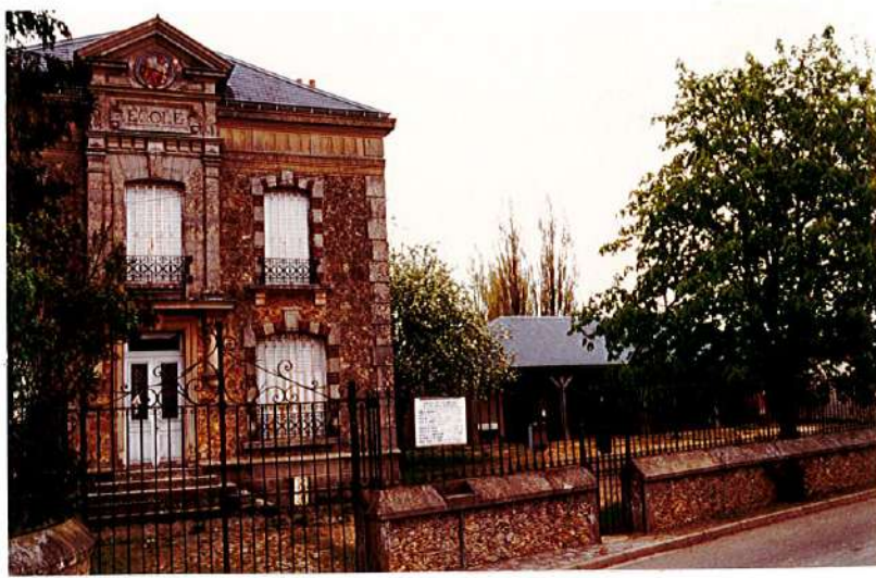
Ancienne école à Saint-Benoît
