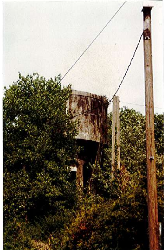
Château d'eau (D 61)
